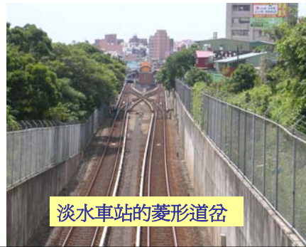
圖 5-28 菱形岔心構造簡圖
