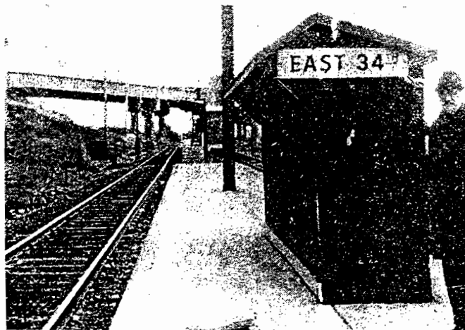
圖 2 - 10 美國利利夫布蘭市之捷運鐵和輕軌運輸系統共軌之情形 (圖中後面為高月台之RRT 的車站；前面為低月台之LRT 的車站)
