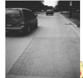
瀝青混凝土修補後產生沉陷 改由連鎖磚修補
