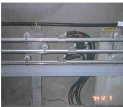
圖 10 供電線路與供電軌接點
