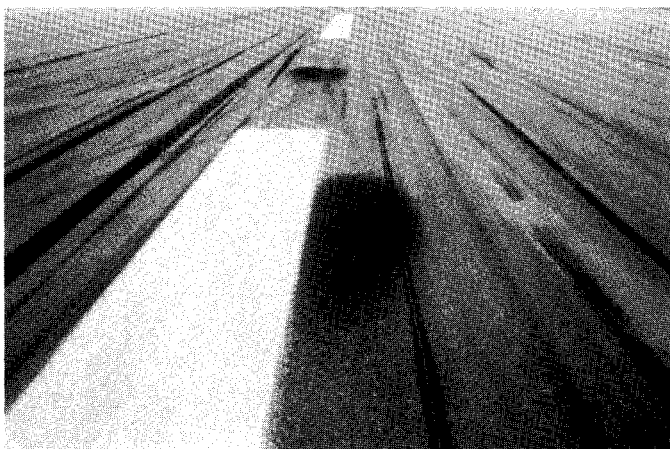
FIG. X1.28 Jet-Blast Erosion
