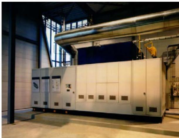
圖 1-17 西門子西屋之熱電合併型 SOFC (照片取材自西門子西屋公司網站)
